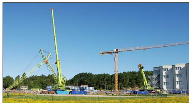
Nya kranar är på plats för att påbörja monteringen av stommen.
