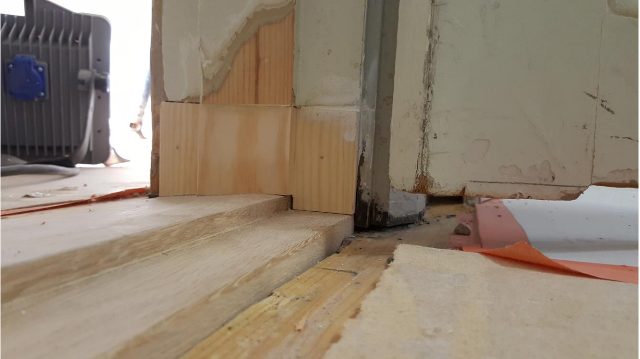
Renovering av karmar och trösklar
